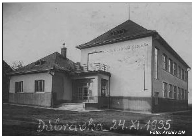
Dúbravská škola v čase dostavby, vidíme, že pozemok ešte nie je oplotený a v záhrade nie sú stromy.
