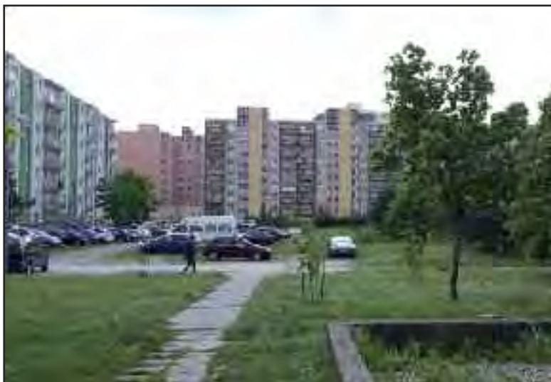
Na časti plochy, kde sa dnes parkuje majú v lokalite Pri kríži vyrásť náhradné byty. Foto: Lucia Marcinátová
