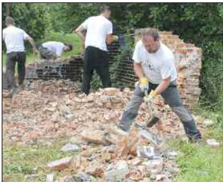
Demontáž starého múru pri Fortune. Plánuje sa tu vynovenie ihriska a lezecká stena.
