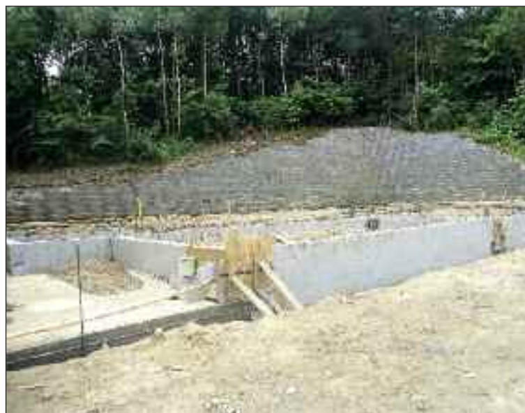
Pohľad na základy nových šatní a tribúny.
