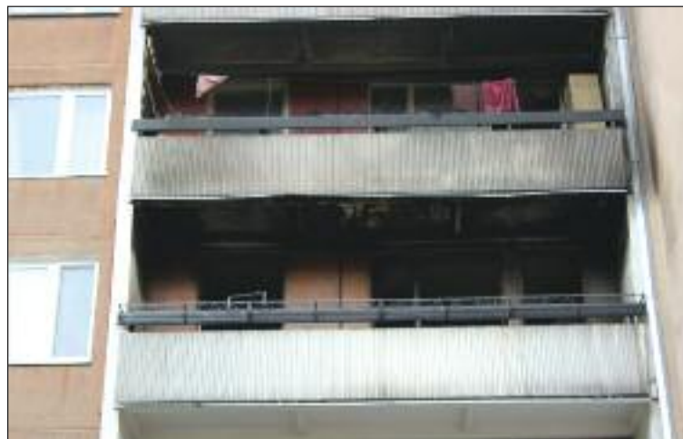
Okno a balkón deň po ničivom požiari na ulici Ľuda Zúbka.
