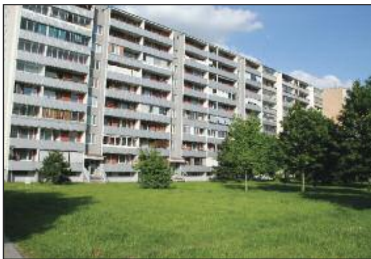
Plocha za Domom služieb na ulici Ľuda Zúbka.
