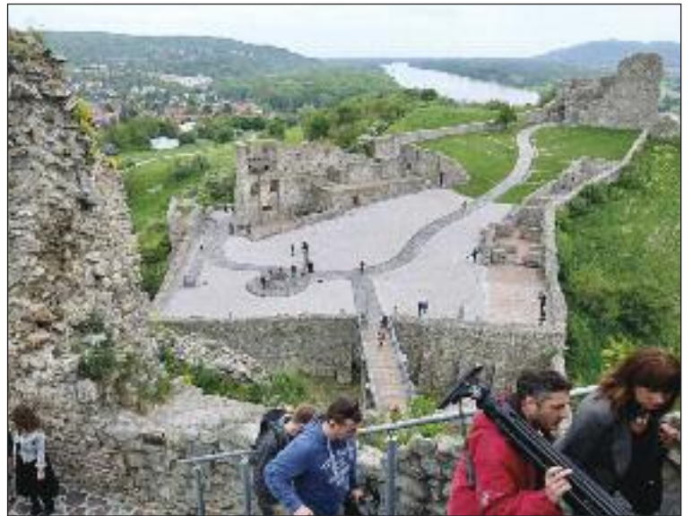
Horný hrad Devín bol zavretý od roku 2008 pre trhlinu v hradnom brale. Teraz opäť ponúka výhľad z hornej citadely.
