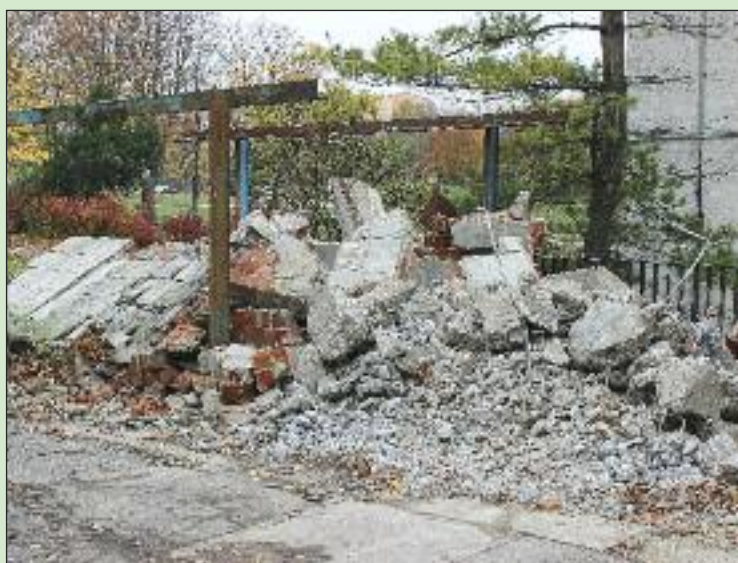
Zbúraný objekt pri Základnej škole Beňovského.
