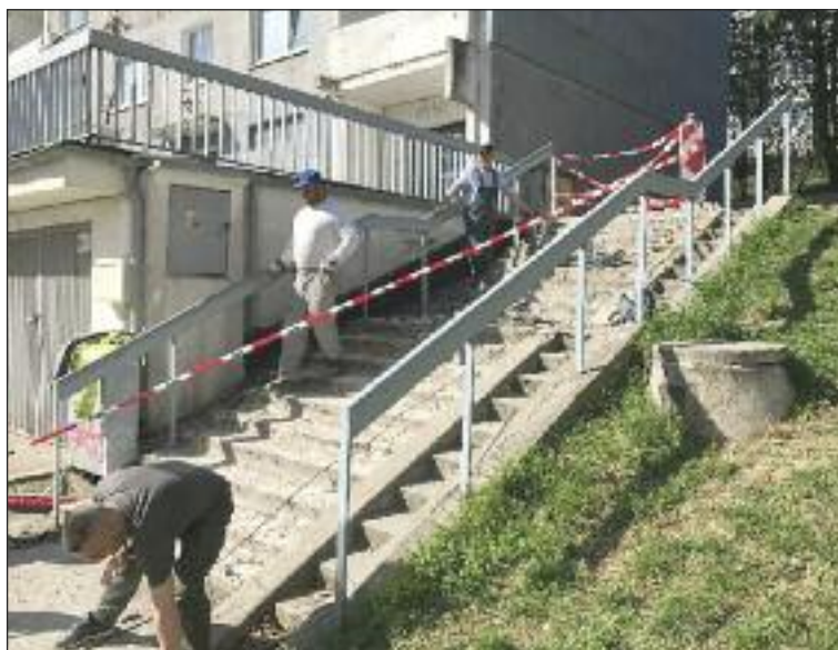
Oprava schodov na Cabanovej.
