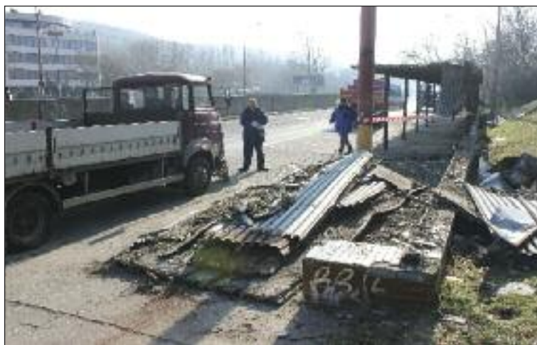
Odstraňovanie starého rozpadávajúceho sa prístrešku na Krčáčoch.
