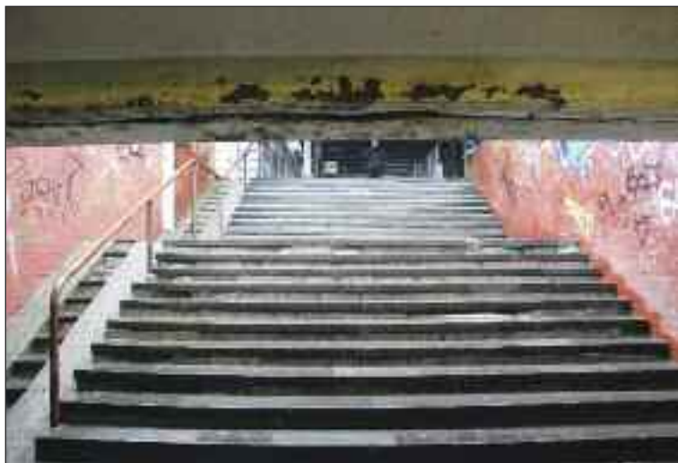
Pohľad na súčasný stav podchodu pri OC Saratov.
