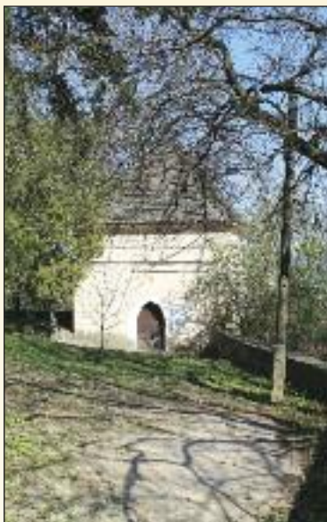
Kaplnka Panny Márie Sedembolestnej, postavená v ranorenesančnom stavebnom slohu tiež zrejme na staršom základe.
