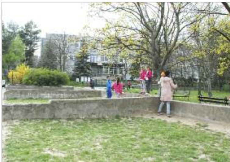
Ihrisko na Ožvoldíkovej pred rekonštrukciou.
