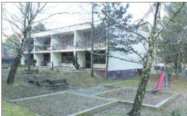
Objekt a areál na Fedákovej pred rekonštrukciou.
