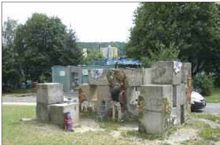
Objekt pre deti počas obnovy, celok – DSCN 1306.
