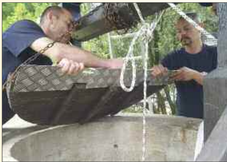
Hasiči namontovali na otvárací drevený poklop studne krycí plech, ktorý zabráni ďalšiemu znečisťovaniu v budúcnosti.
