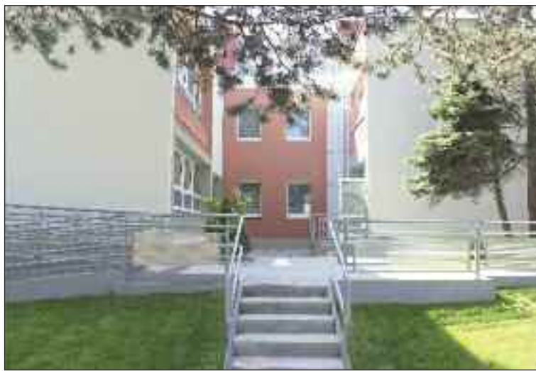
Budova materskej školy dnes.
