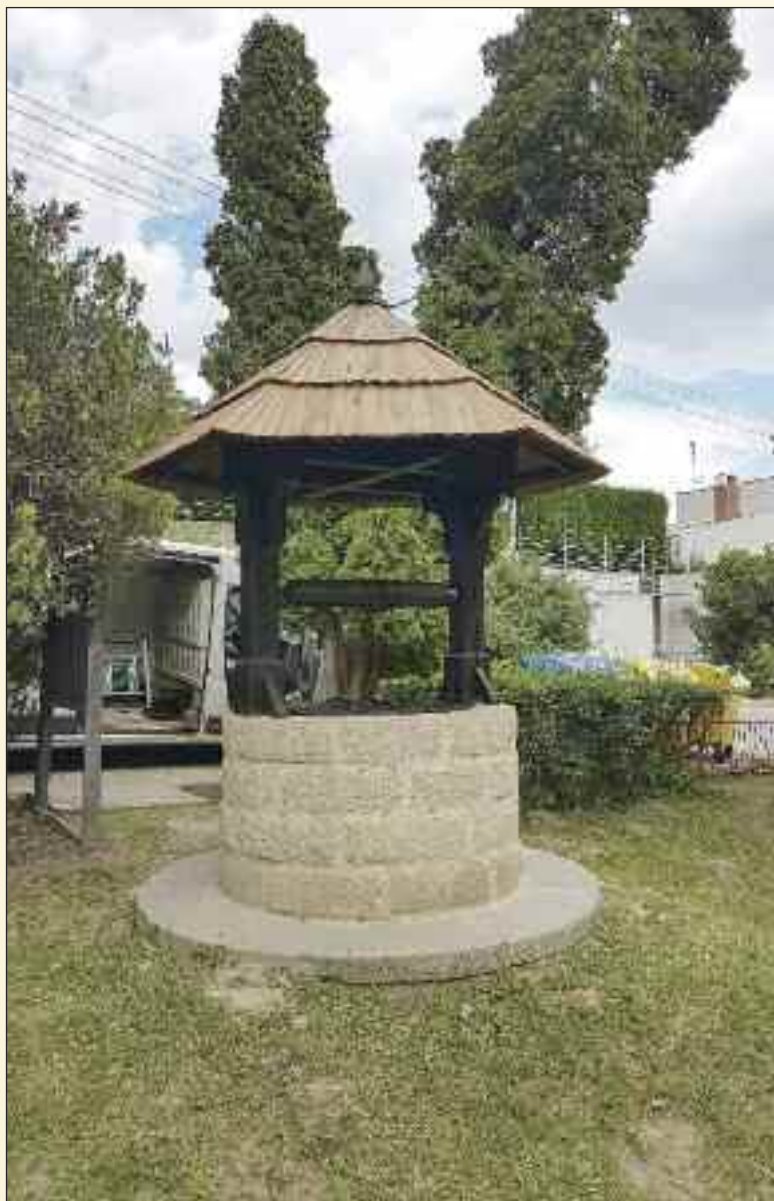
Dubová konštrukcia studne bola zdravá, jedľový šindel na strieške bolo potrebné vymeniť a ošetriť ochranným náterom.
