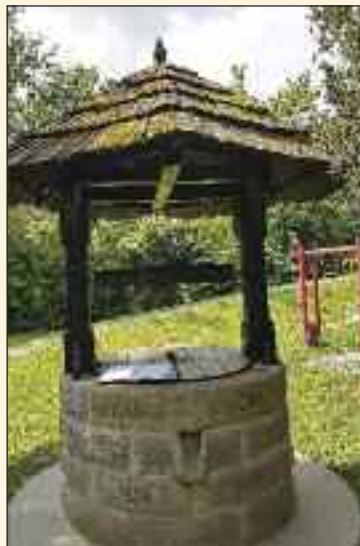
Horanská studňa pred obnovou a počas prác. Šindel bol z veľkej časti spráchnivený. Foto: Mária Smiešková
