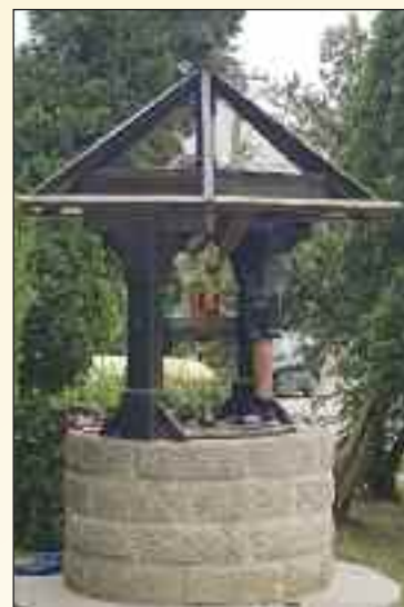
Horanská studňa pred obnovou a počas prác. Šindel bol z veľkej časti spráchnivený. Foto: Mária Smiešková
