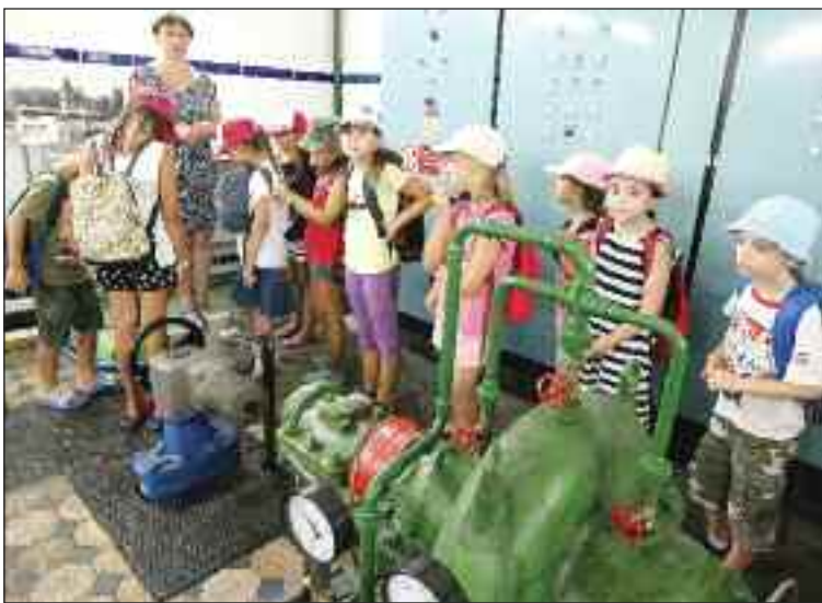
V strojnici čerpacej stanice na ostrove Sihot'.
