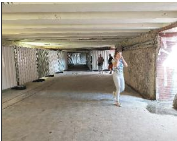
Oprava podchodu bola jednou z priorít mestských poslancov za Dúbravku – Juraja Káčera a Zdenky Zaťovičovej.
