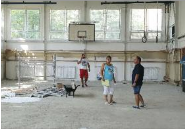
Telocvična ZŠ Nejedlého počas prác.
