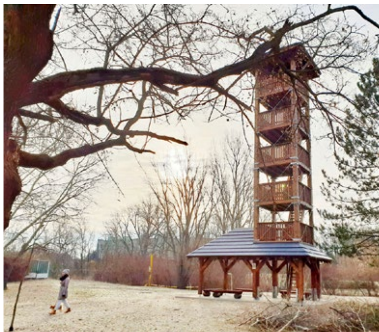
Nosná konštrukcia veže je tvorená drevenými hranolmi.
