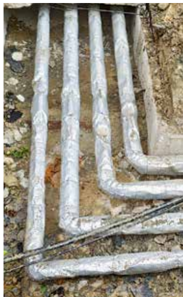
Pôvodný stav rozvodov
