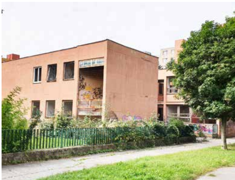
Objekt na Ulici kpt. Rašu chátra
