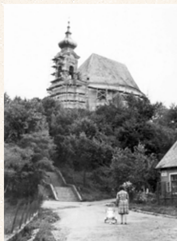
Kostol sv. Kozmu a Damiána v čase rekonštrukcie v sedemdesiatych rokoch minulého storočia.
