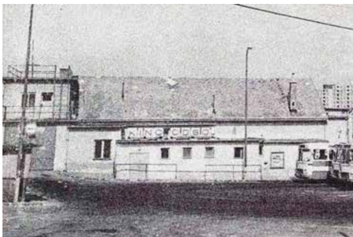
Hasičská zbrojnica a niekdajšie Kino Odboj na Jadranskej. Zbrojnica a skladové priestory mesta dnes.
