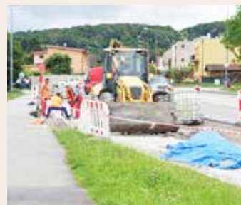
Rekonštrukcia ulice Pri kríži.
