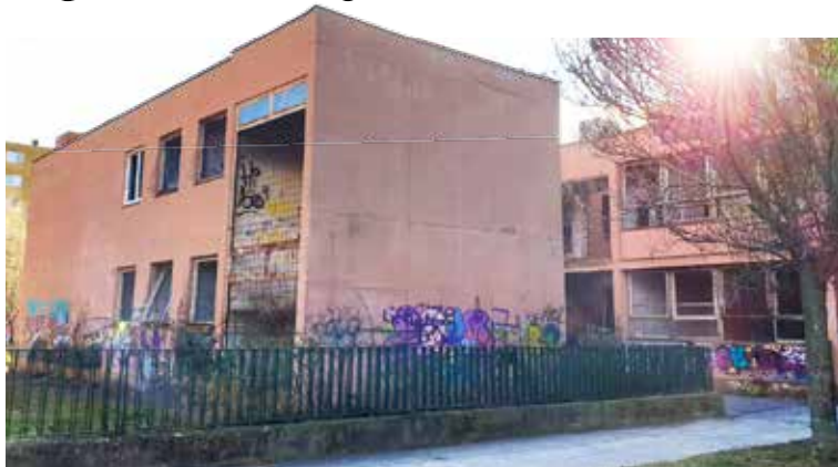
Chátrajúci objekt na Ulici kpt. Rašu.
