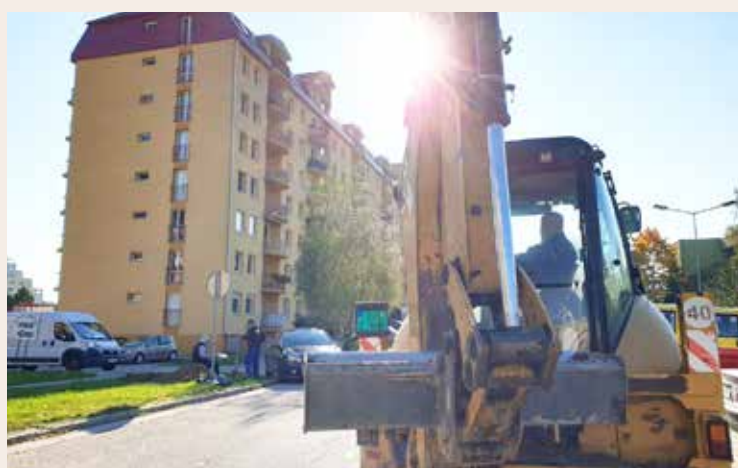
Práce na rozširovaní parkovacích miest na ulici Pod záhradami.
