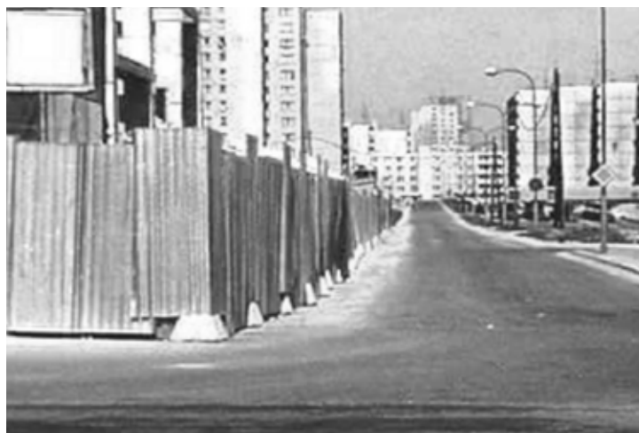
Odbočenie na Trhovú ulicu spoza Domu kultúry Dúbravka.
