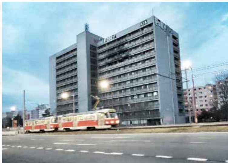
Ohorená niekdajšia ubytovňa pri hlavnej ceste.
