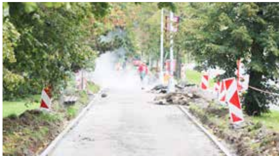
Veľká oprava chodníka na Alexyho
