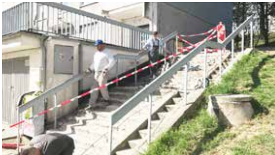
Obnova schodiska na Cabanovej ulici.
