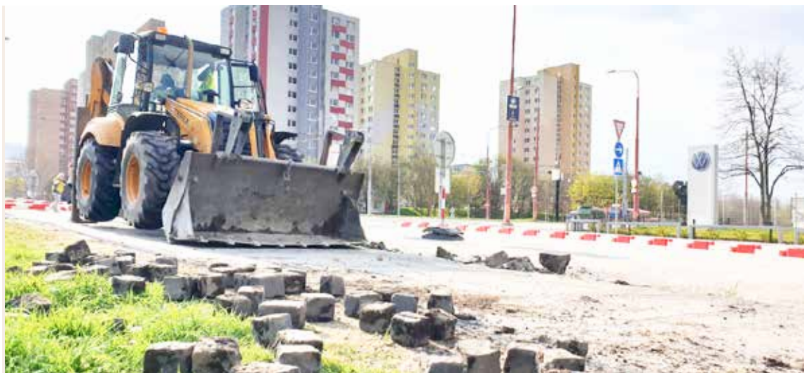
Rekonštrukcia Dúbravčickej ulice.
