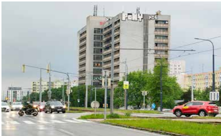
Chátrajúci objekt niekdajšej ubytovne.
