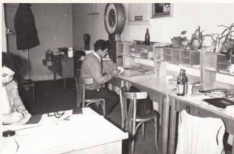
Budova (horná fotografia) a interiér pošty Bratislava 15 v Lamači (stav asi v roku 1973), z ktorej sa doručovali poštové zásielky aj do Dúbravky.
