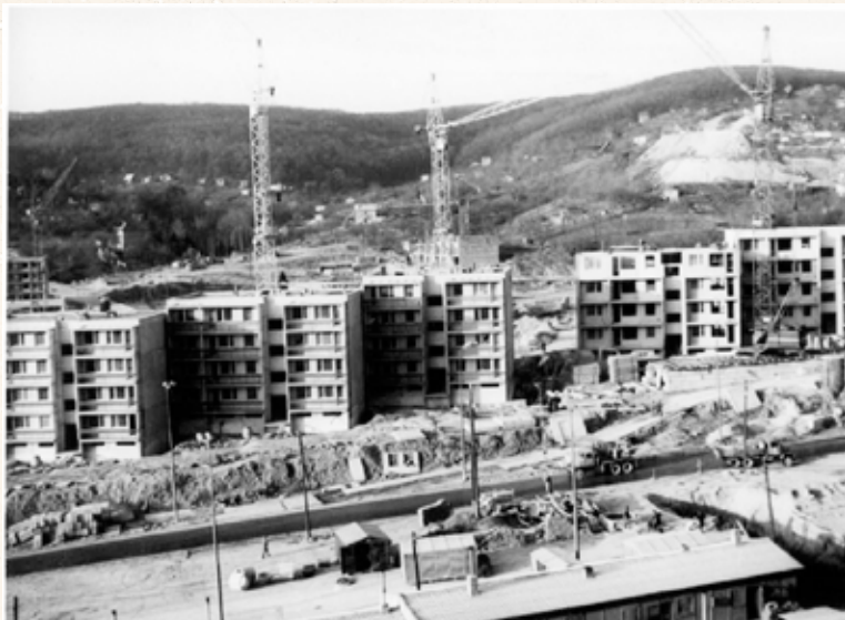
Pohľad z okna bytu na dnešnej Landauovej ulici na výstavbu bytových domov na Galbavého ul. (Záluhy 2).
