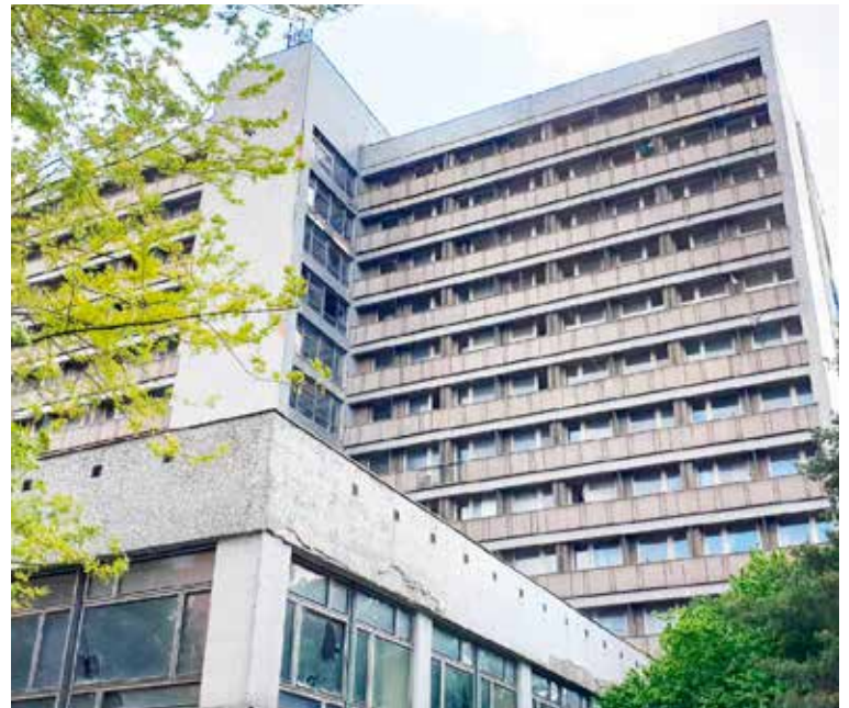
Ubytovňa roky chátra.
