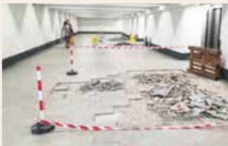
Dlažba v podchode sa opäť vymieňala. Foto: Lucia Marcinátová
