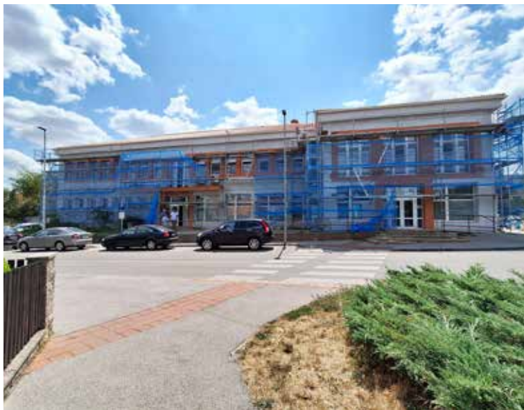
Zatepľovanie budovy miestneho úradu na Žatevej.
