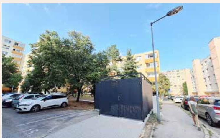
Nové kontajnerové stojisko na Gallyovej ulici.
