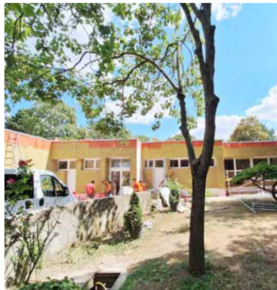
Zateplovanie Materskej školy Damborského.
