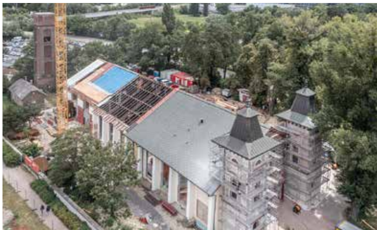
Divadlo Aréna počas rekonštrukcie.
