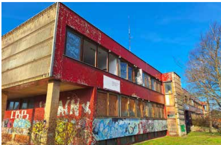
Objekt starej pošty.
