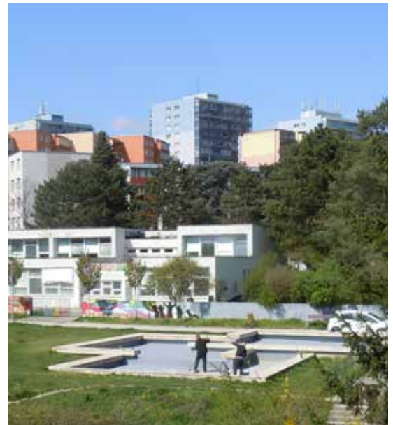
Fontána na Bazovského ulici počas prác, celkový záber. Foto: autorka
