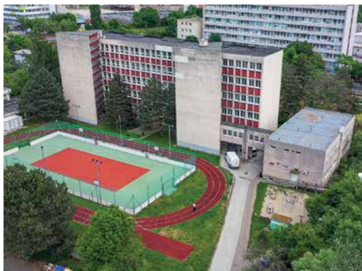
Obchodná akadémia, Račianska 107 pred rekonštrukciou
