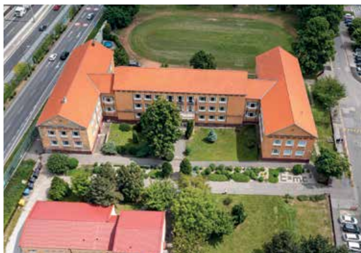
Gymnázium Alberta Einsteina pred rekonštrukciou
