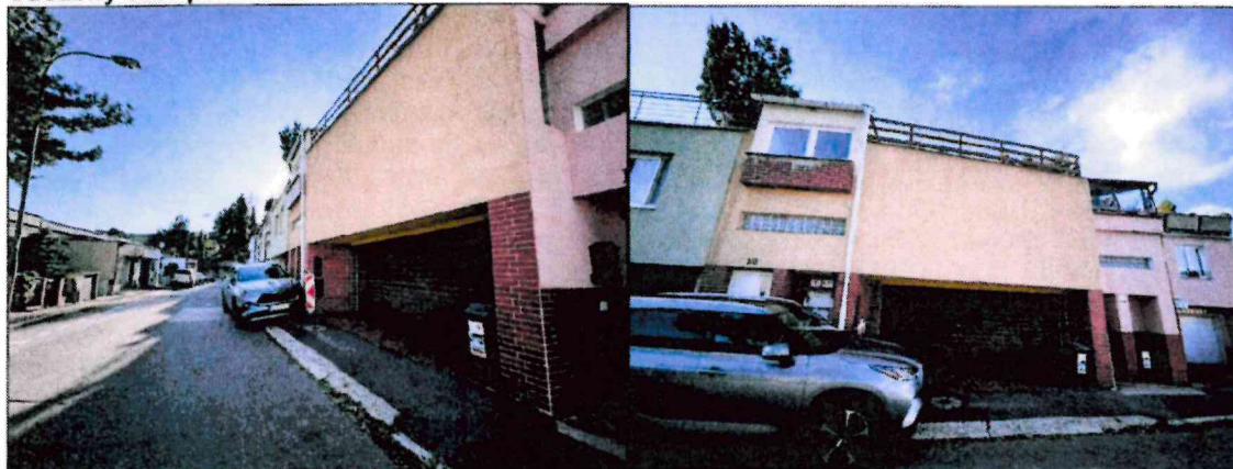
Pozemok vjazdu do garáže a so vstupom do domu
