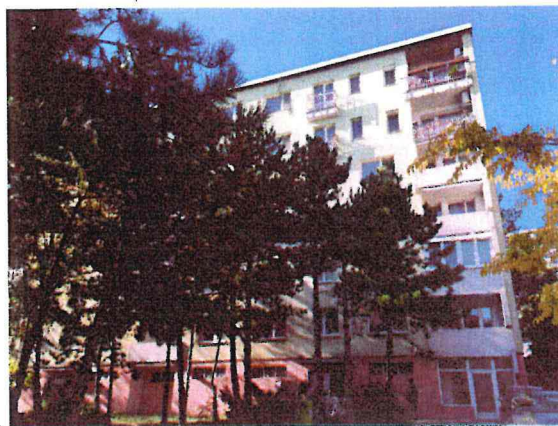
Bytová dom Cabanova 13, k. ú. BA – Dúbravka.
